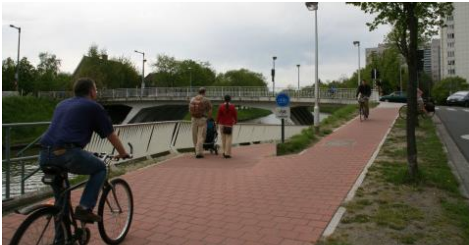
Foto Fietsbult: Onderdoorgang Europabrug Gent
