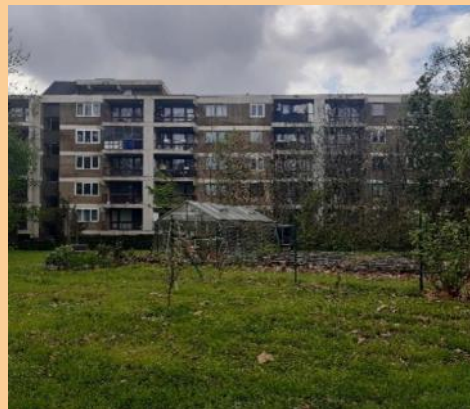
Zicht op hoogbouw en gedeelde serre
