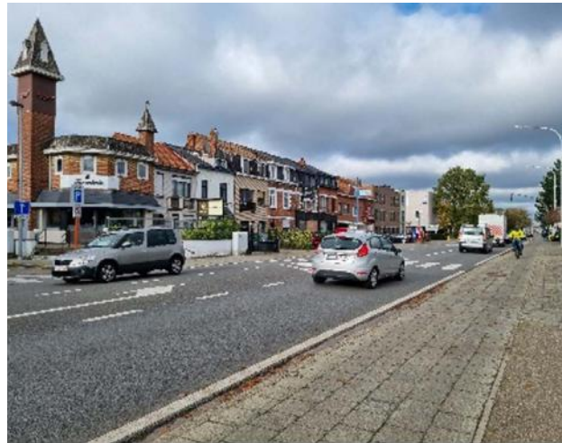
Drukke wegen met vaak defecte verlichting
